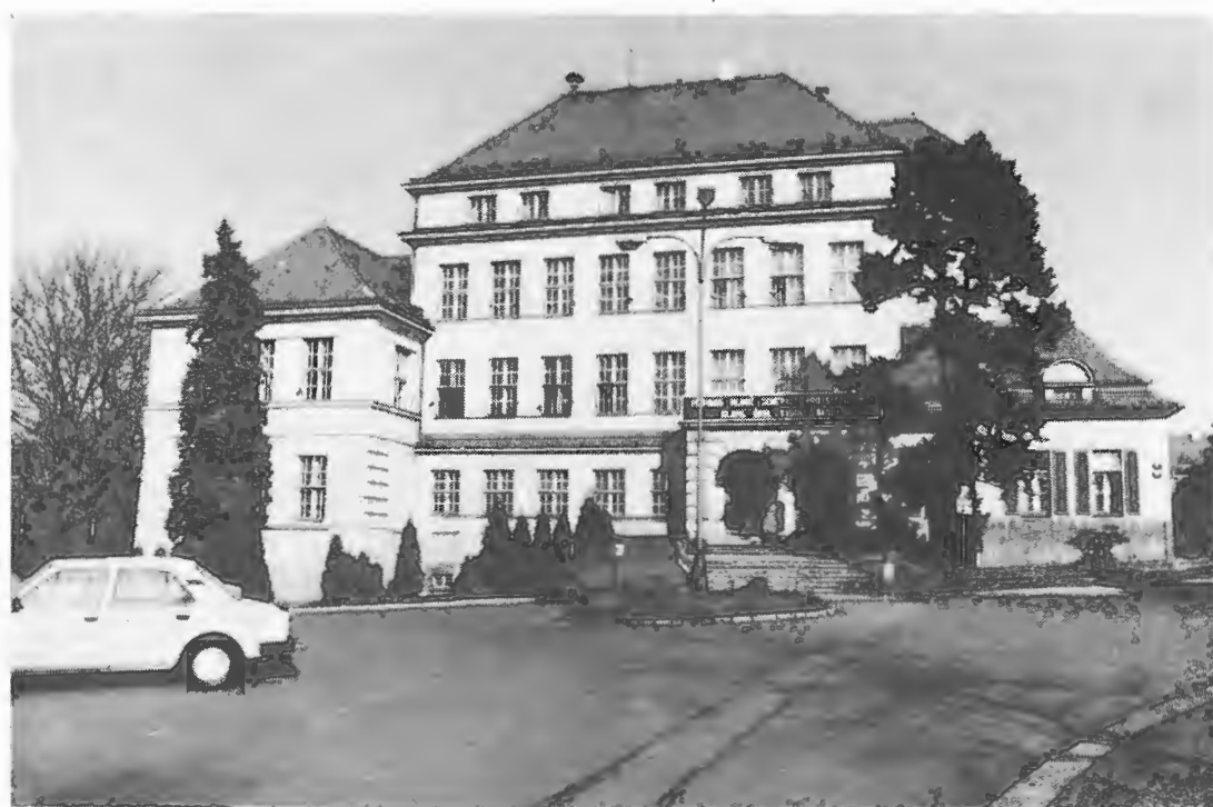
Budova rektorátu VŠST
